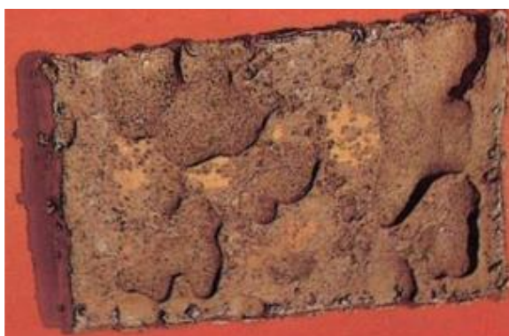
Figura 17: Corrosão por placa.
