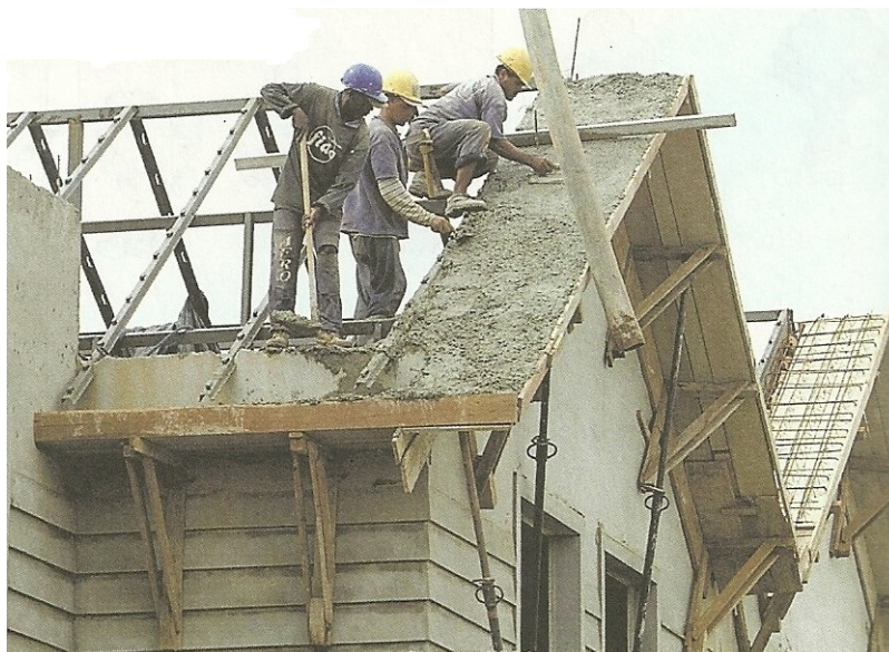
Figura 2 – Presença de triângulos no telhado de uma casa.
