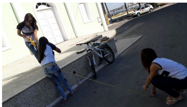
Figura 89 – Tamanho da Futura Rampa
