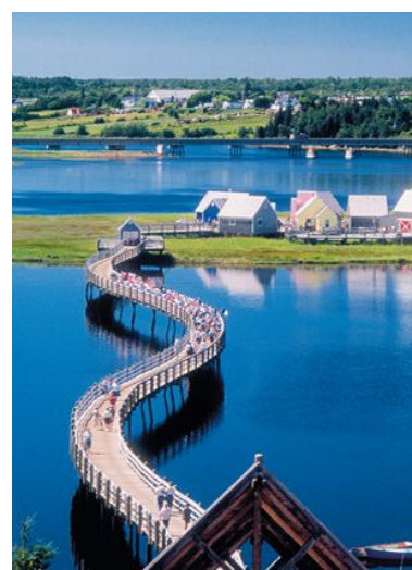
Figura 31 – Ponte em Moncton, CAN.
