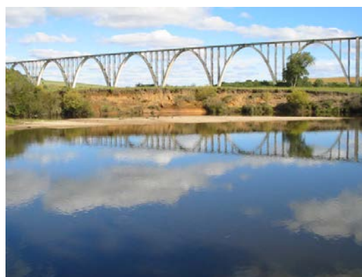
Figura 29 – Ponte dos Arcos, PR.
