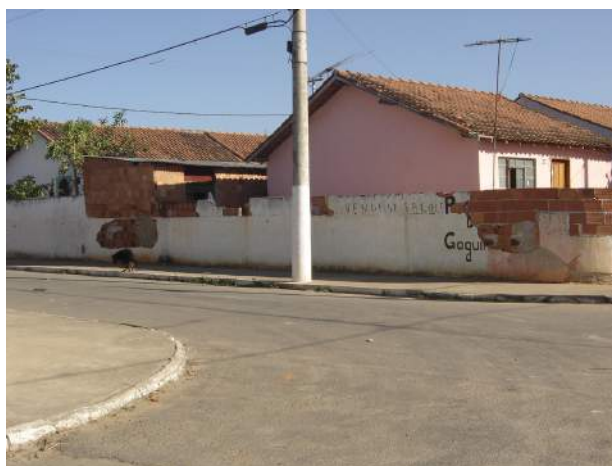
Figura 25: Nesta foto podemos ver uma casa sendo construída no quintal. Fonte: acervo próprio.
