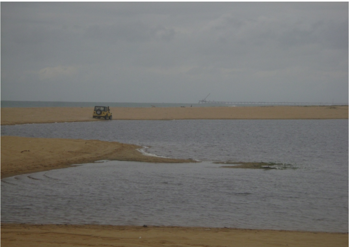
IMAGEM 21- vista da porto em construção nas margens da Lagoa de Iquipari
