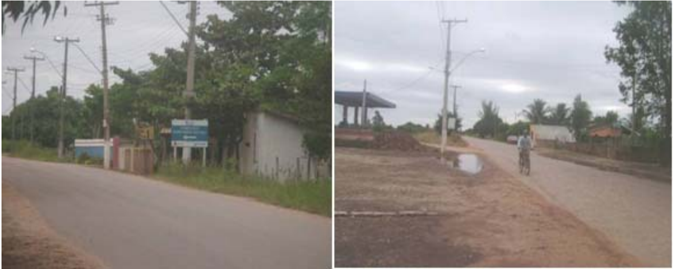
IMAGEM 10- Estrada e caminho de acesso ao complexo portuário-industrial.
