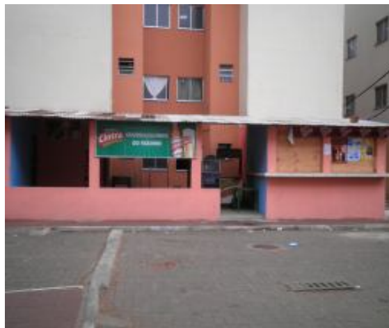
Fig. 13 – “Churrasquinho do Fabinho” (em alvenaria, de frente a um bloco e interditando a calçada) [arquivo pessoal].
