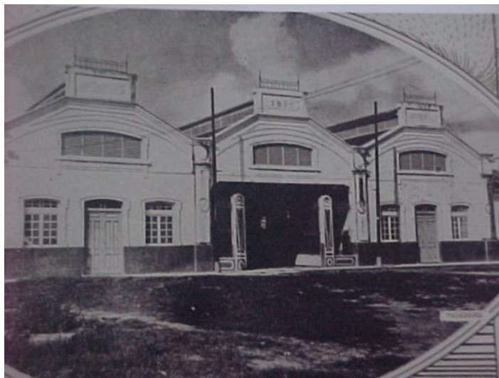
Figura 2: Prédio do matadouro modelo, inaugurado em 1929 [arq. Foto Planície IN POHLMANN (2004)].
