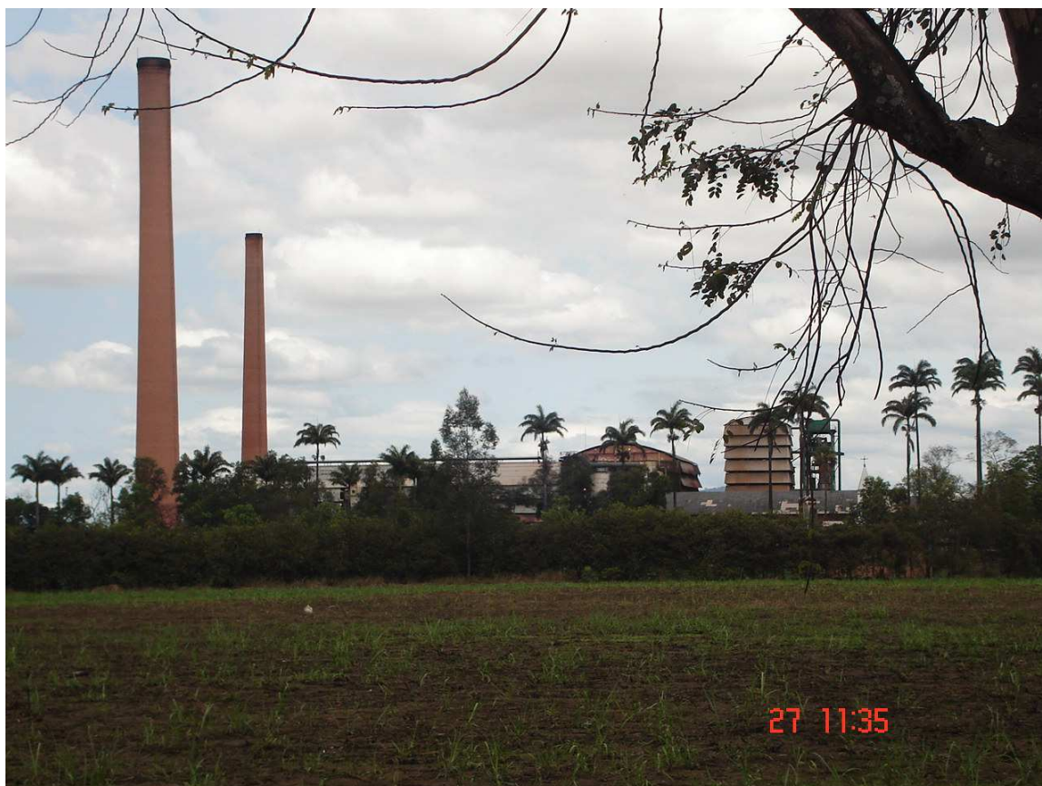
FIGURA 3 - Usina Sapucaia em Campos dos Goytacazes: maior unidade industrial da região.
