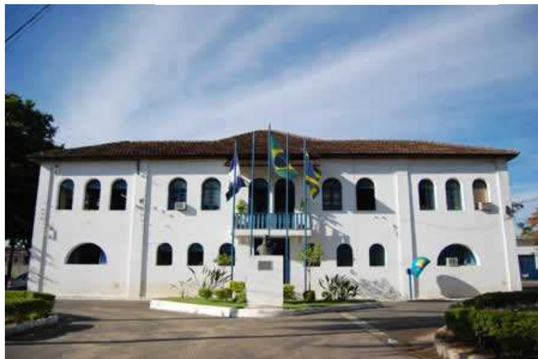
Prédio Sede da FMIJ
