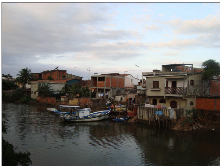
Figura 18 - Construções ilegais à margem do canal Campos-Macaé na Nova Brasília/Macaé Foto da autora (2008)
