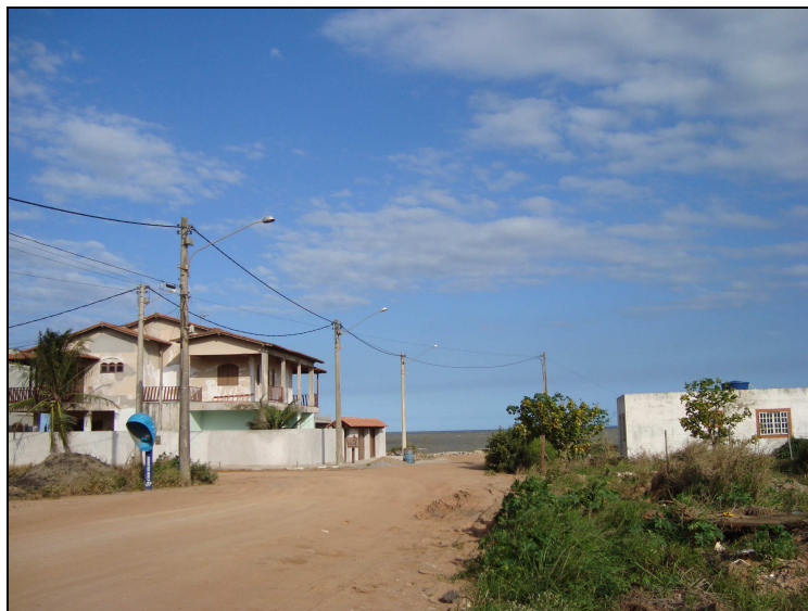
Figura 15 - Imóveis construídos em áreas de restinga no bairro São José do Barreto Foto da autora (2008)
