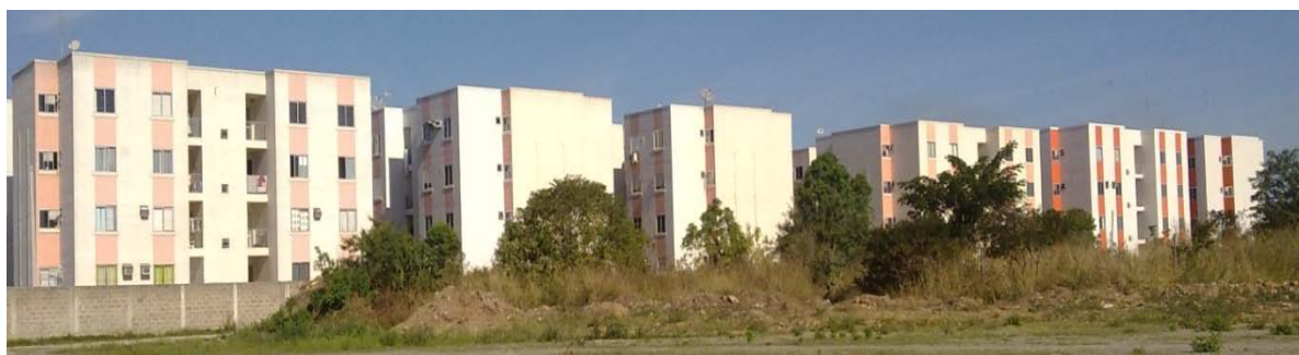
Figura 20 - Condomínio vertical Dr. Elias construído no bairro Parque Califórnia, área periférica da cidade, para população de menor status socioeconômico. Fonte: Arquivo pessoal, 2011.
