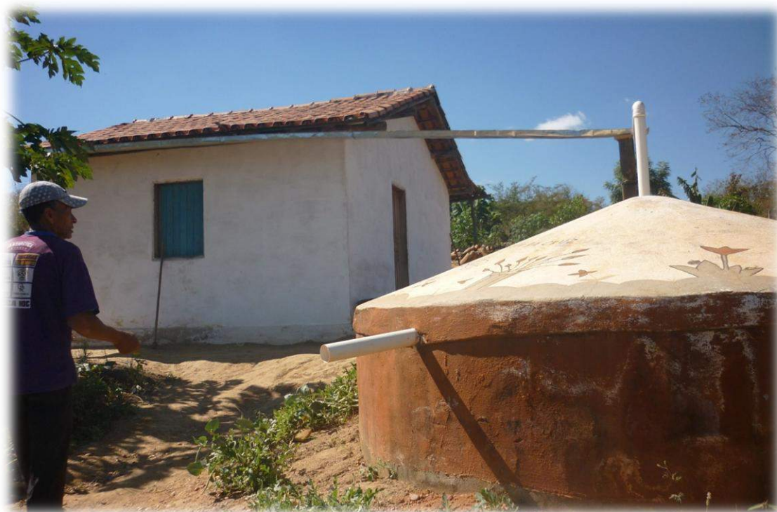
Figura 12: Sistema de coleta de águas pluviais. Projeto do CPCD.
