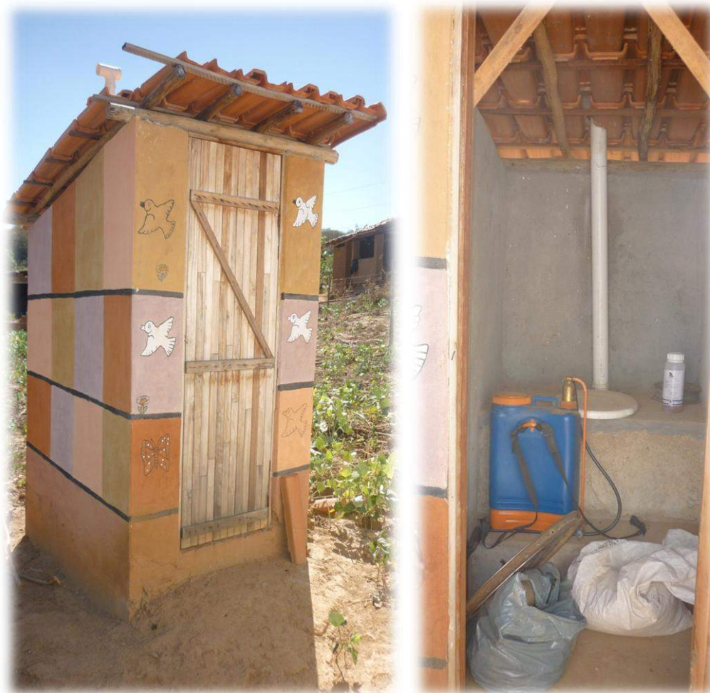
Figura 11: Banheiro de composto de serragem. Projeto do CPCD.
