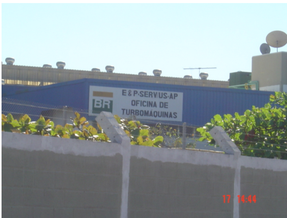
Foto 17- À esquerda da vicinal, no acesso sentido RJ-106 – LENEP.
