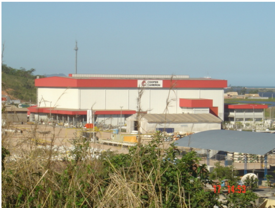
Foto 22 – Correspondente às imagens tomadas nas fotografias 2 e 3, sendo que tomada do alto da colina, no mesmo sentido da giratória descrita na foto 21 37 .
