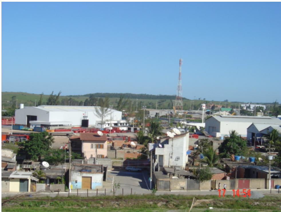
Foto 24 – Correspondente ao exibido de frente nas fotografias 7, 8 e 9. A comunidade de moradores na faixa inferior da fotografia.
