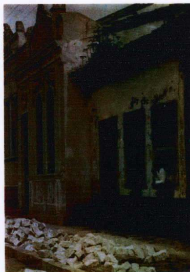
Fig.28 – recorte da fotografia 27, destacando a casa colonial, ou melhor, um cortiço - presença do casal negro, na janela. O estado de conservação do prédio é péssimo e com as transformações ocorridas neste espaço brevemente será demolida (foto arq. CEFET/Campos)
