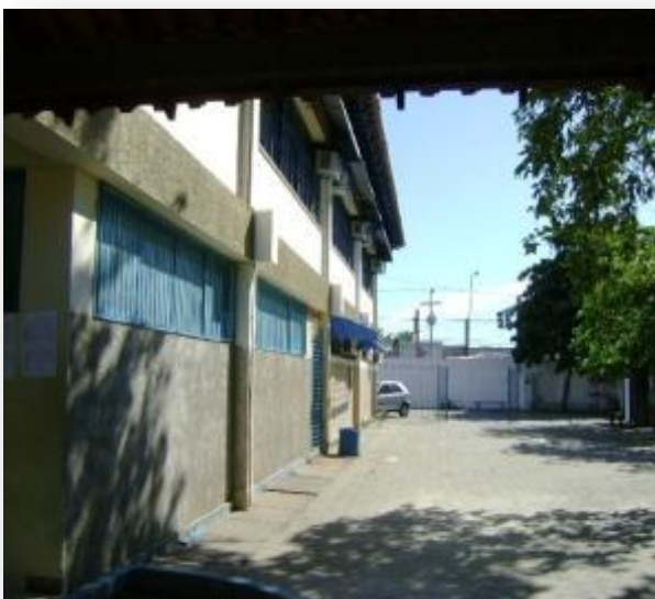
FOTO 2: Fachada frontal do prédio
