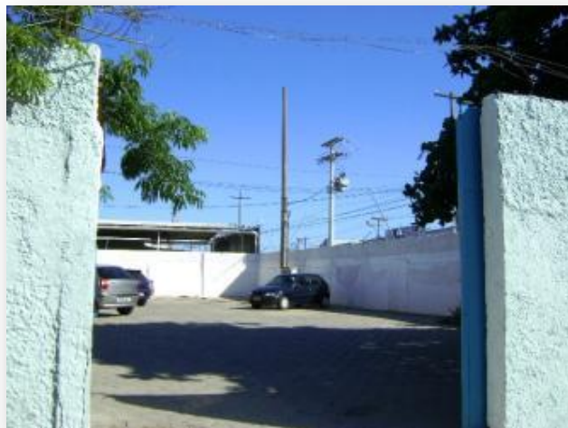
FOTO 4: Portão de entrada de veículos
