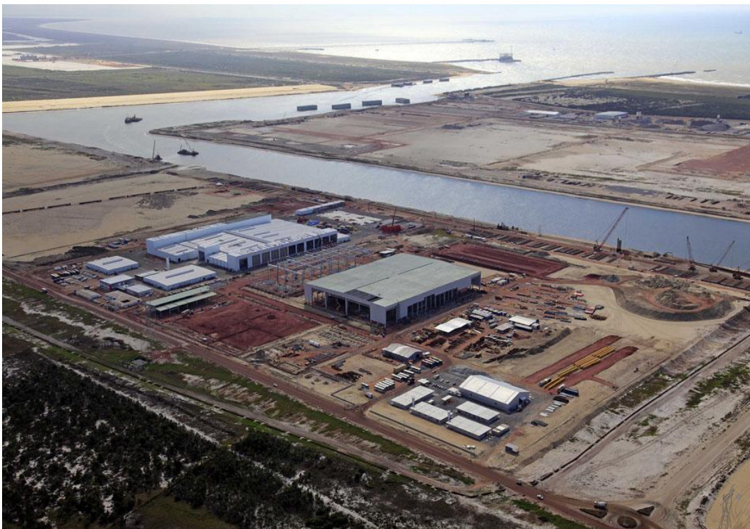
Figura 9 - Vista Aérea do Complexo Industrial do Superporto do Açu em Julho de 2013. Fonte: http://www.prumologistica.com.br/pt/galeria-multimedia/Paginas/acompanhamento-obras-todos.aspx?&AnoObra=2013&MesObra=07.Julho .
