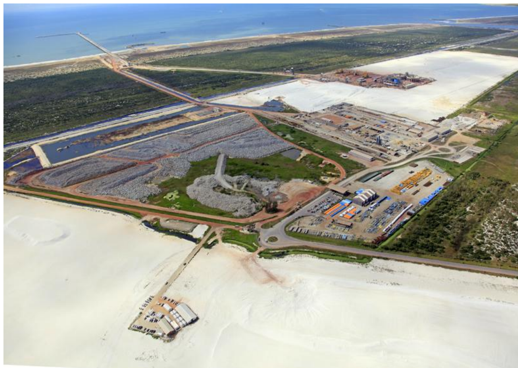
Figura 8 - Vista Aérea do Complexo Industrial do Superporto do Açú em Agosto de 2012. Fonte: http://www.prumologistica.com.br/pt/galeria-multimedia/Paginas/acompanhamento-obras-todos.aspx?&AnoObra=2012&MesObra=08.Agosto .
