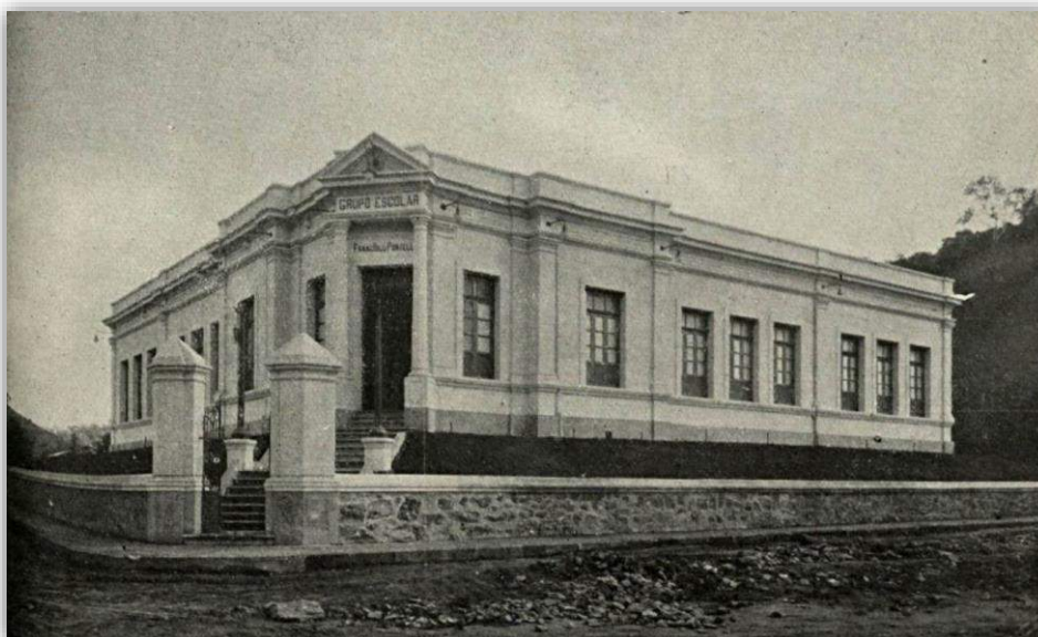
Figura 36 – Fachada do G. E. Francisco Portella em Natividade, município de Itaperuna
