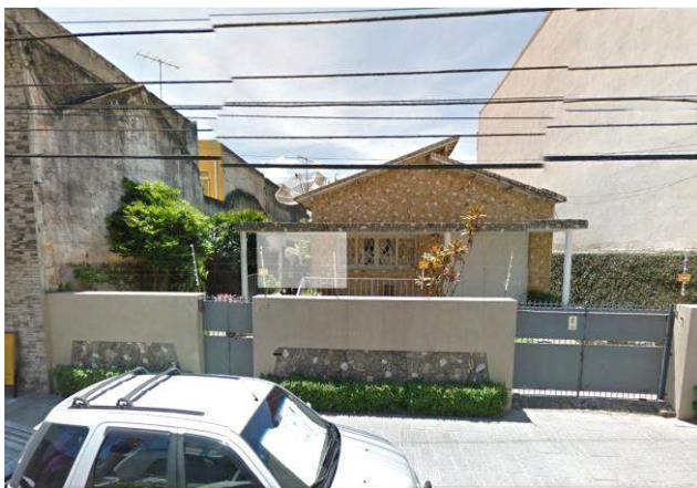
Figura 60 – Local onde se localizava o prédio que abrigou a 1ª Escola Complementar de Campos, em 1911, regida pela professora Izabel de Freitas Guimarães.
