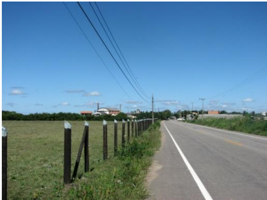
Figura 11 - Visão panorâmica da Usina de Tócos;
