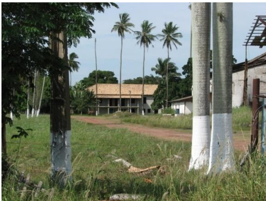
Figura 17 - Antiga sede administrativa da Usina Cambaíba;
