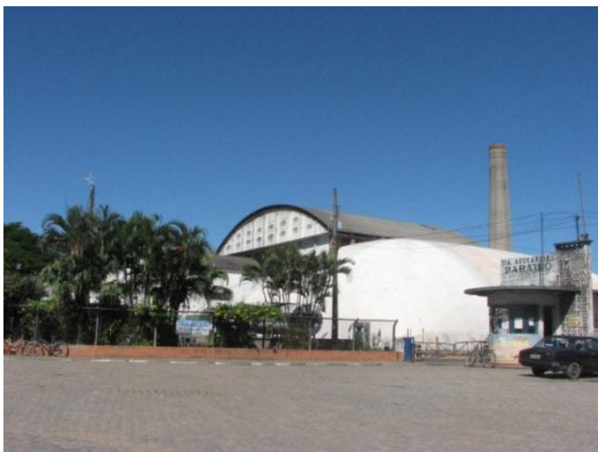
Figura 10 - Visão frontal da Usina de Tócos;
