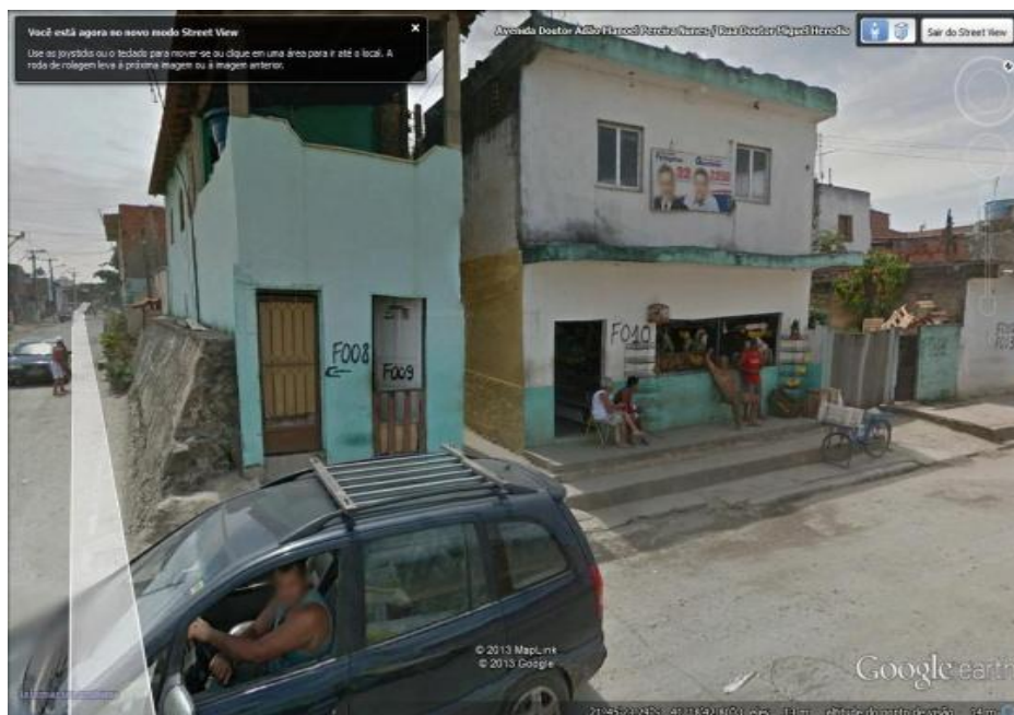
Figura 13: casas e comércios marcados para demolição
