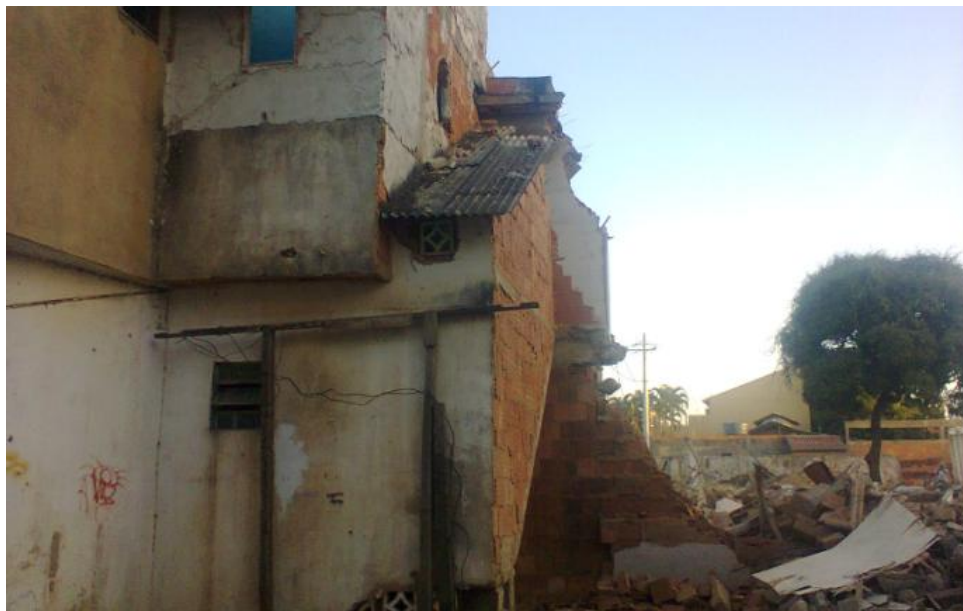
Figura 17: casas e comércios sendo demolidas
