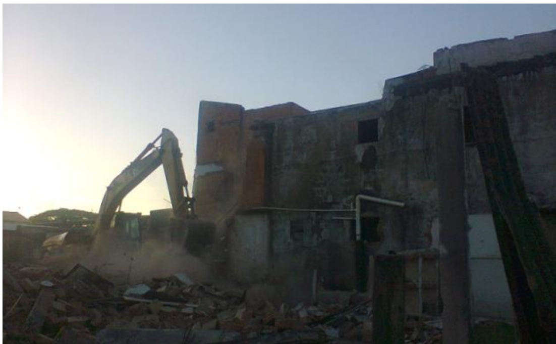
Figura 15: casas e comércios sendo demolidas
