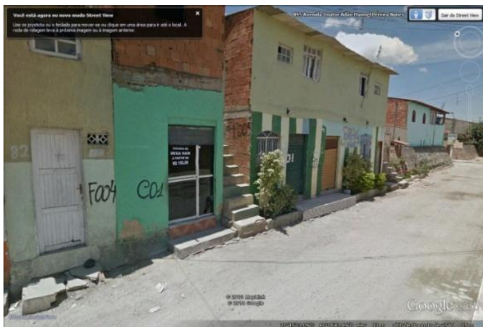
Figura 14: casas e comércios marcados para demolição
