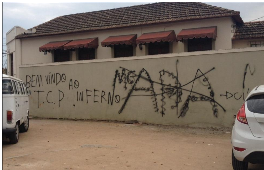
Figura 15: Foto do muro de casa localizada no cruzamento da Avenida Professor Carmen Carneiro com a Rua Santo Antônio – Jardim Carioca, Subdistrito de Guarus.
