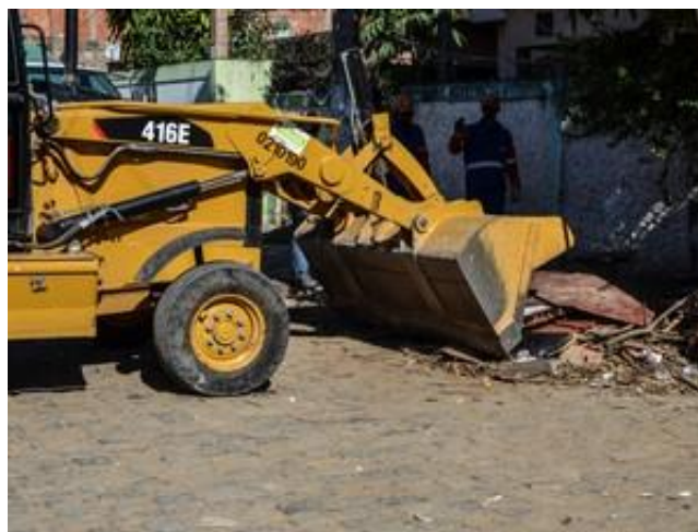
Máquinas retiraram barricadas da Baleeira (Foto: Letícia Bucker/G1)
