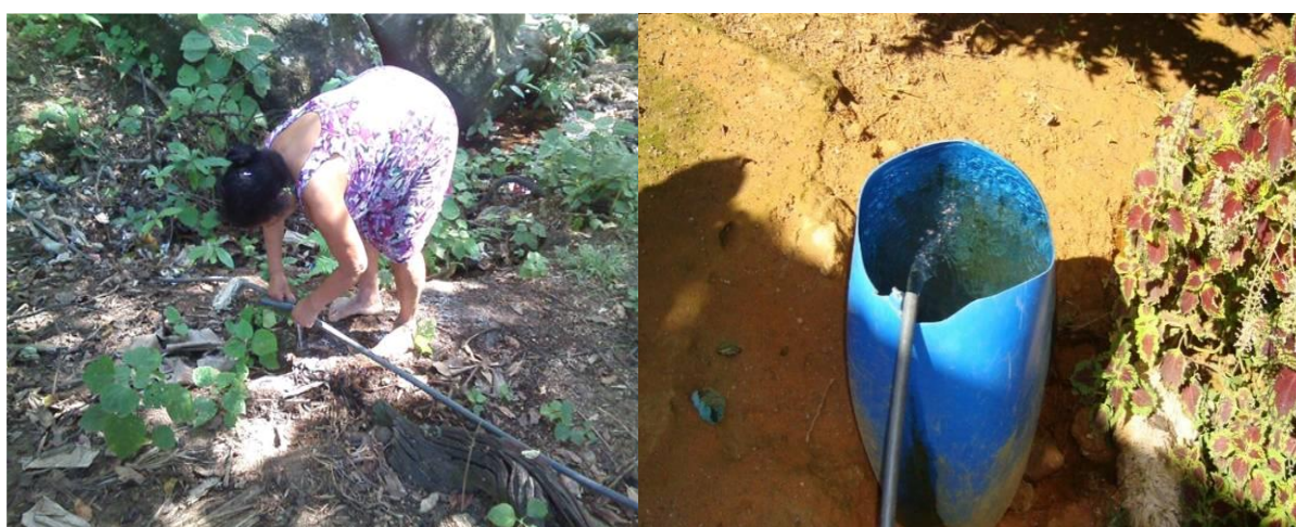
Figura 12. À esquerda moradora consertando encanamento improvisado e à direita ponto de abastecimento de água ininterrupto. Fonte: Arquivo da autora.
