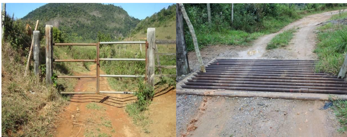
Figura 3. À esquerda cancela antes da ação do Ministério Público (2013). À direita substituição por mata-burro (2015). Fonte: Arquivo da autora
