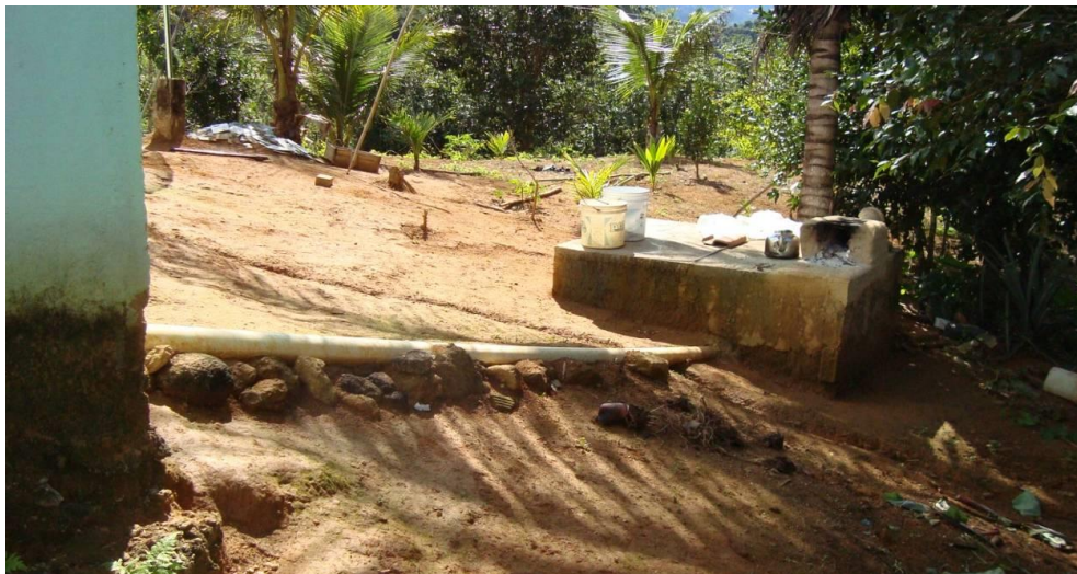
Figura 13. Fossa séptica de residência. Fonte: Arquivo da autora.
