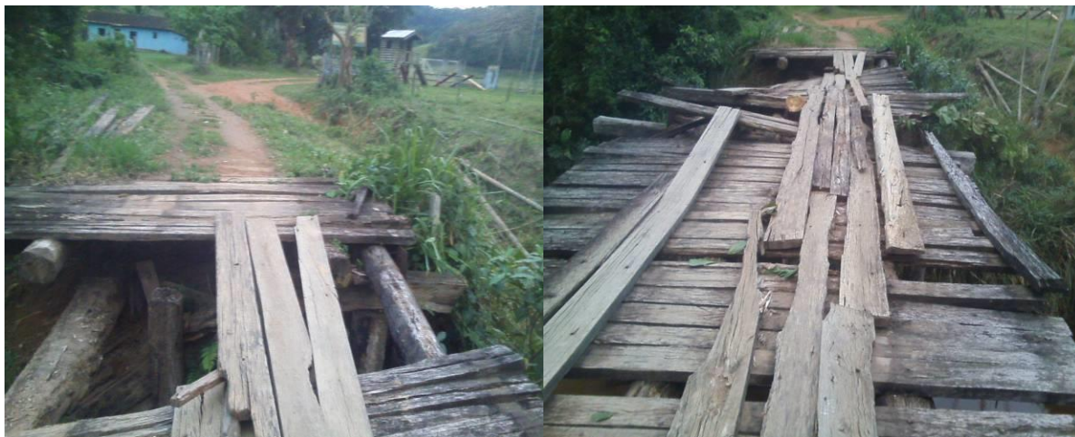
Figura 4. Ponte de acesso à escola municipal Santa Rita. Fonte: Arquivo da autora.
