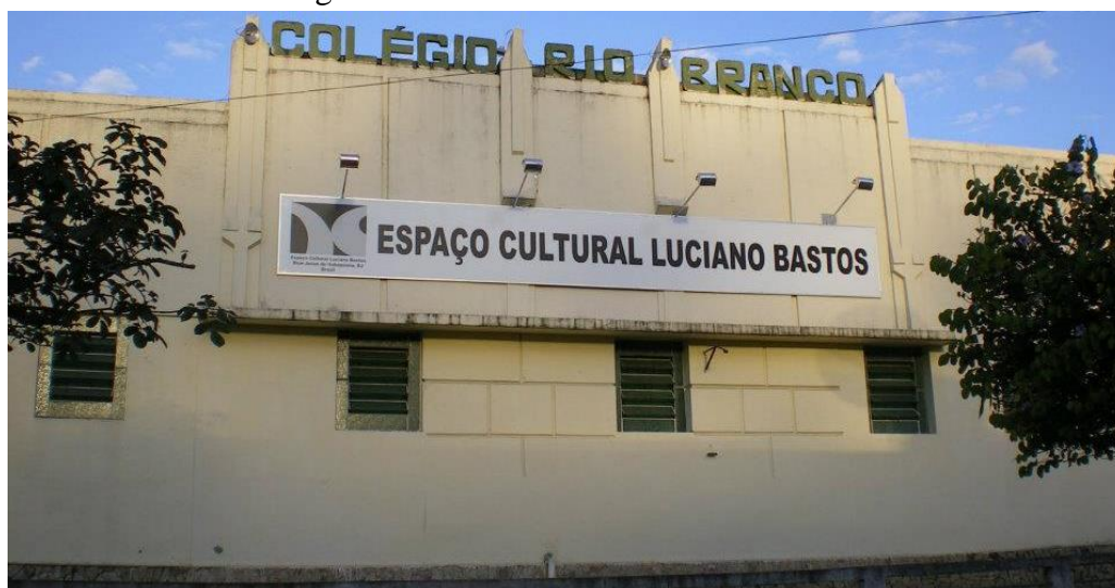
Fotografia 3 - Prédio do CRB em 2011.
