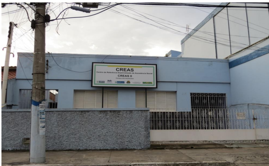
Figura 2: Localização do CREAS - II que está situado na Rua dos Goytacazes, nº 618 - Turf-Club.
