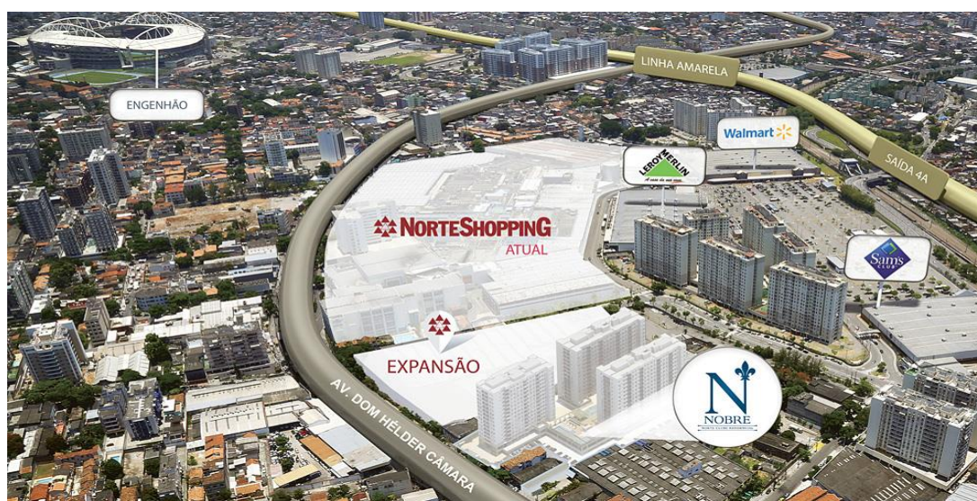
Figura 19 – Imagem aérea do Note Shopping, onde pode-se perceber a quantidade de empreendimentos imobiliários e de serviço no seu entorno
