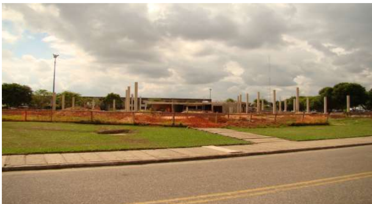
Figura 3: Obra da Construção do restaurante universitário da UENF Fonte: Arquivo pessoal de professor da instituição
