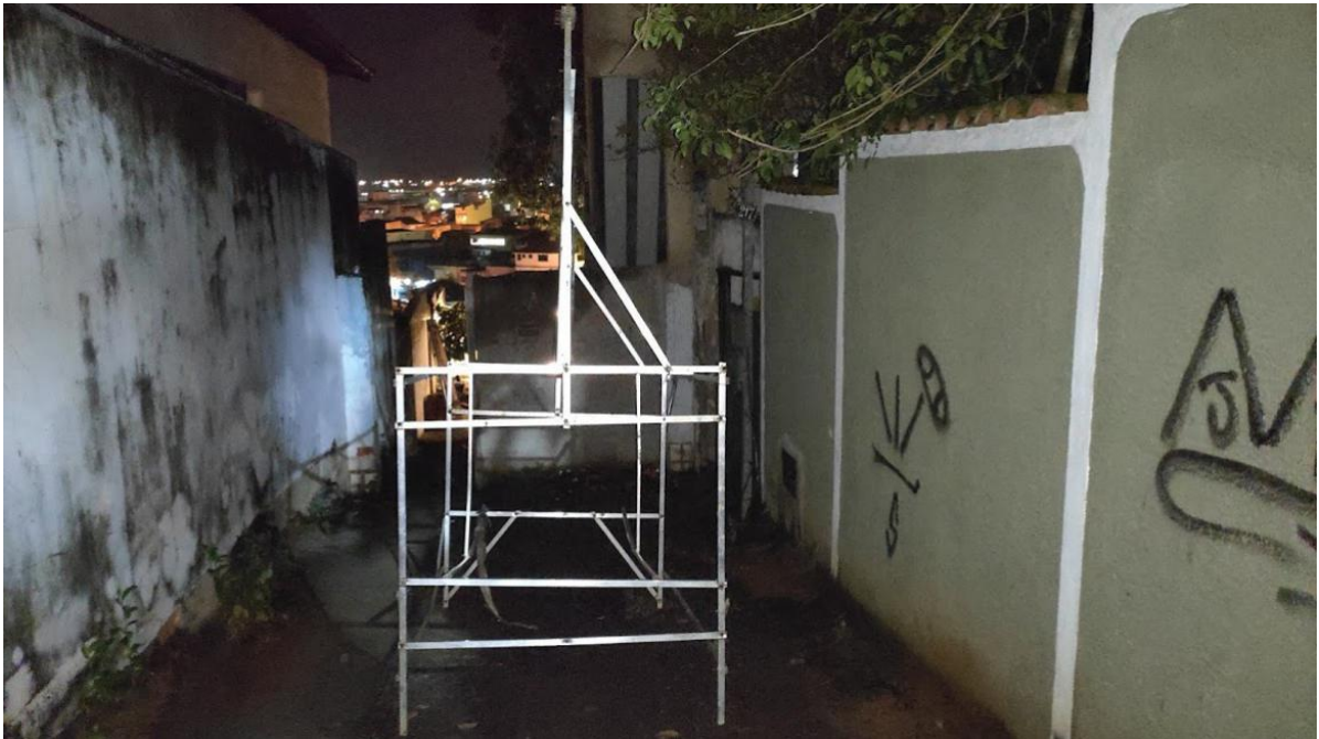
Foto 11 - Quadro de alumínio, sobre o qual será montado o restante da estrutura Fonte: Arquivo pessoal do autor (2020)
