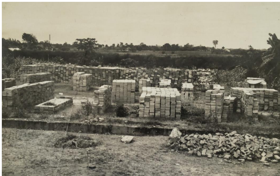
Figura 4- Fotografia: 1.ª Etapa da construção do Educandário. Abertura dos alicerces, fundações e lajes de piso (1960)
