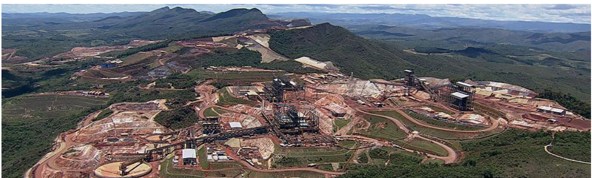
Foto 5: Planta de beneficiamento Minas-Rio. Fonte: Anglo American, 2014.
