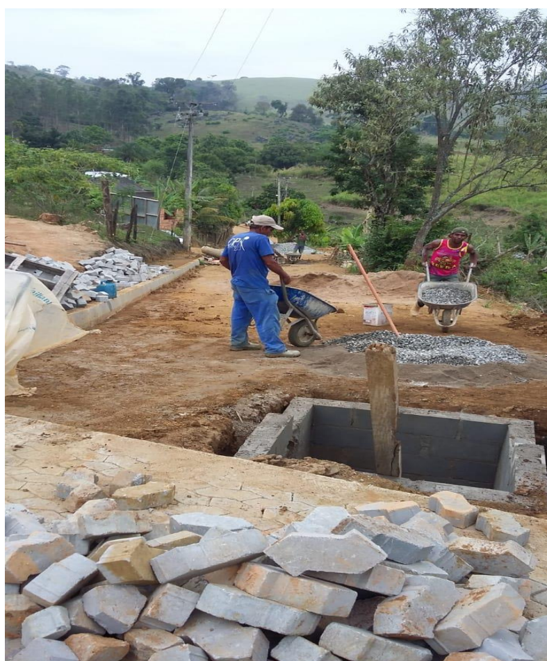
Figura 10 – Pavimentação da rua que dá acesso ao CHMCMV em Pedra Branca Fonte: Acervo próprio, agosto de 2018.
