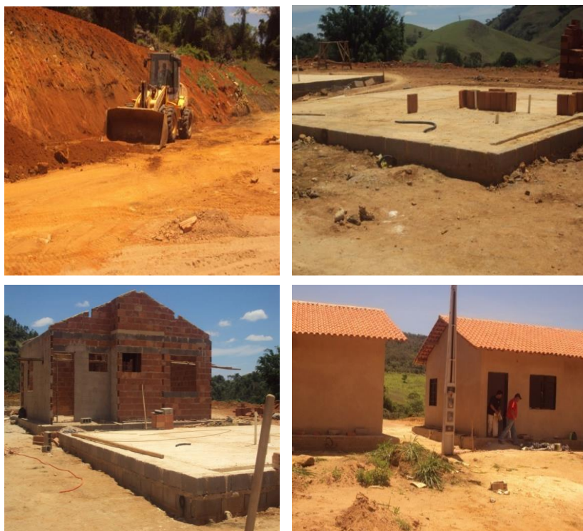
Figura 9 - Construção do CHMCMV Fonte: Acervo próprio, 2018.
