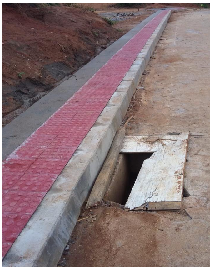
Figura 11 – Pavimentação da rua que dá acesso ao CHMCMV em Pedra Branca Fonte: Acervo próprio, novembro de 2018.
