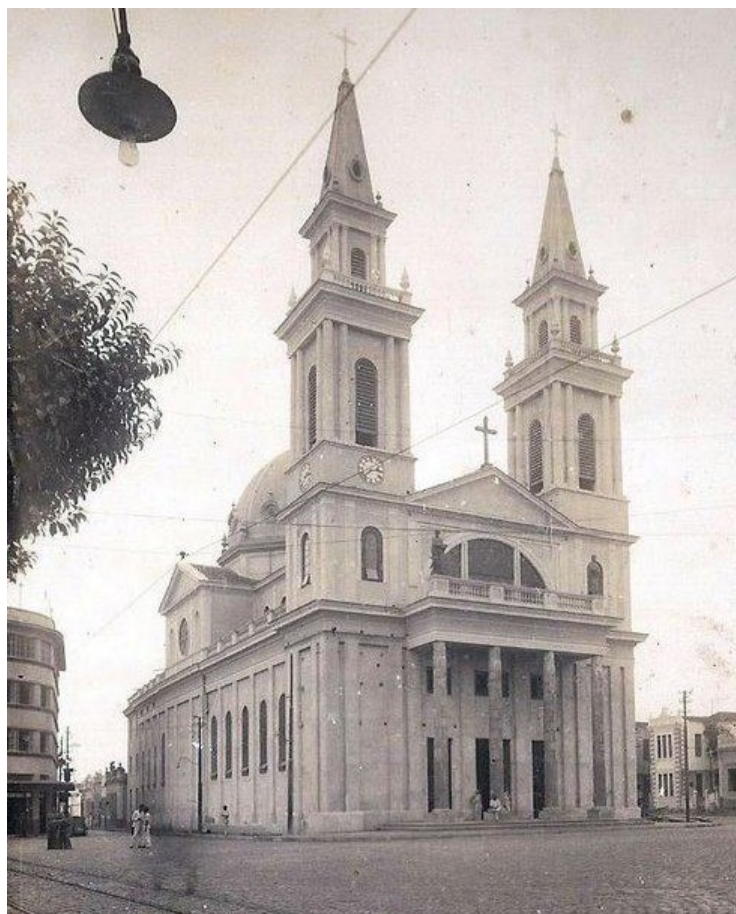
Figura 12 - Catedral diocesana de Campos dos Goytacazes, ainda em obras, às vésperas de sua inauguração
