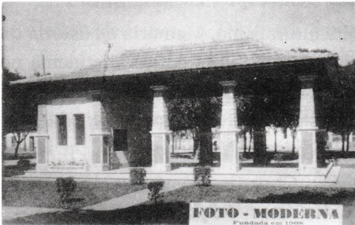
Figura 26 - Pavilhão das aulas do Instituto Claparède
