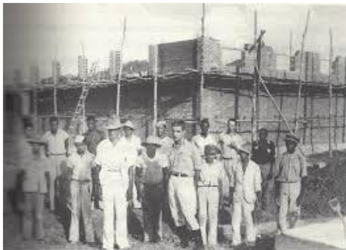
Figura 2: Construção do cinema na Usina Santa Maria, em 1952. Fonte: Pinto (2004, p.77)
