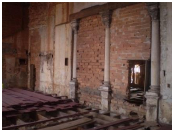
Figura 13: 2º andar afetado pelo incêndio. Fonte: acervo pessoal da autora.
