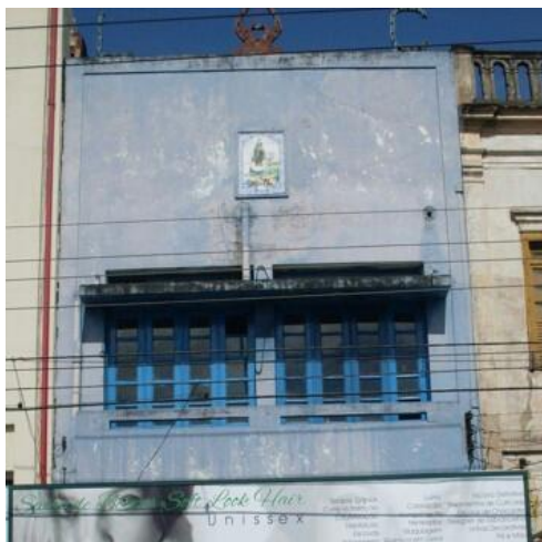
Figura 34: Fachada antes da reforma. Fonte: acervo doado pela Banda.
