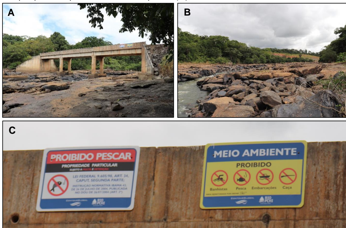
Figura 30 - Trecho de vazão reduzida da PCH Pedra do Garrafão (A e B), com destaque para as placas fixadas na ponte (C)
