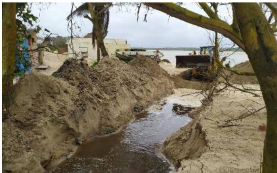
Fotografia 9 - Abertura de Vala para drenar esgoto/líquidos acumulados
