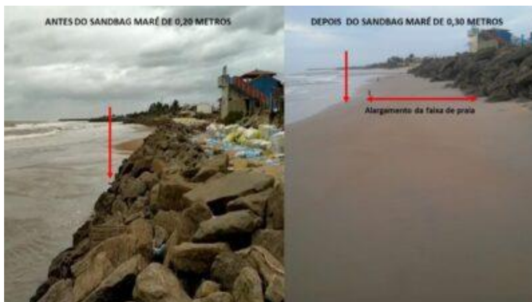
Fotografia 33 - Utilização de SANDBAG.
