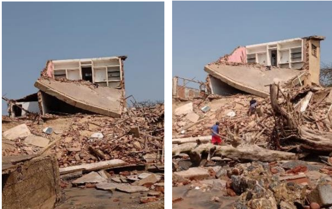
Fotografia 22 - Casa em escombros. Reciclagem dos materiais.
