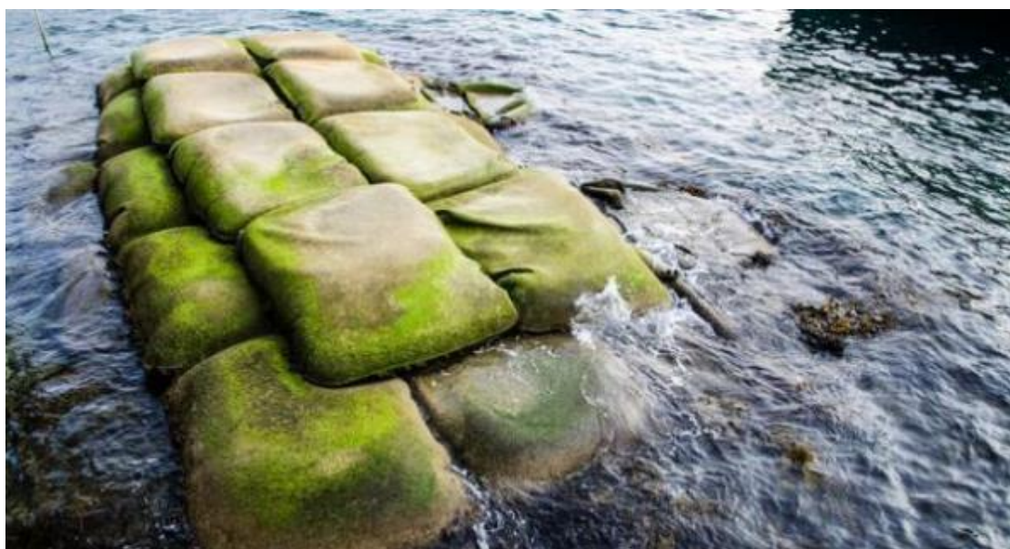
Fotografia 32 - Utilização de Geobags.
