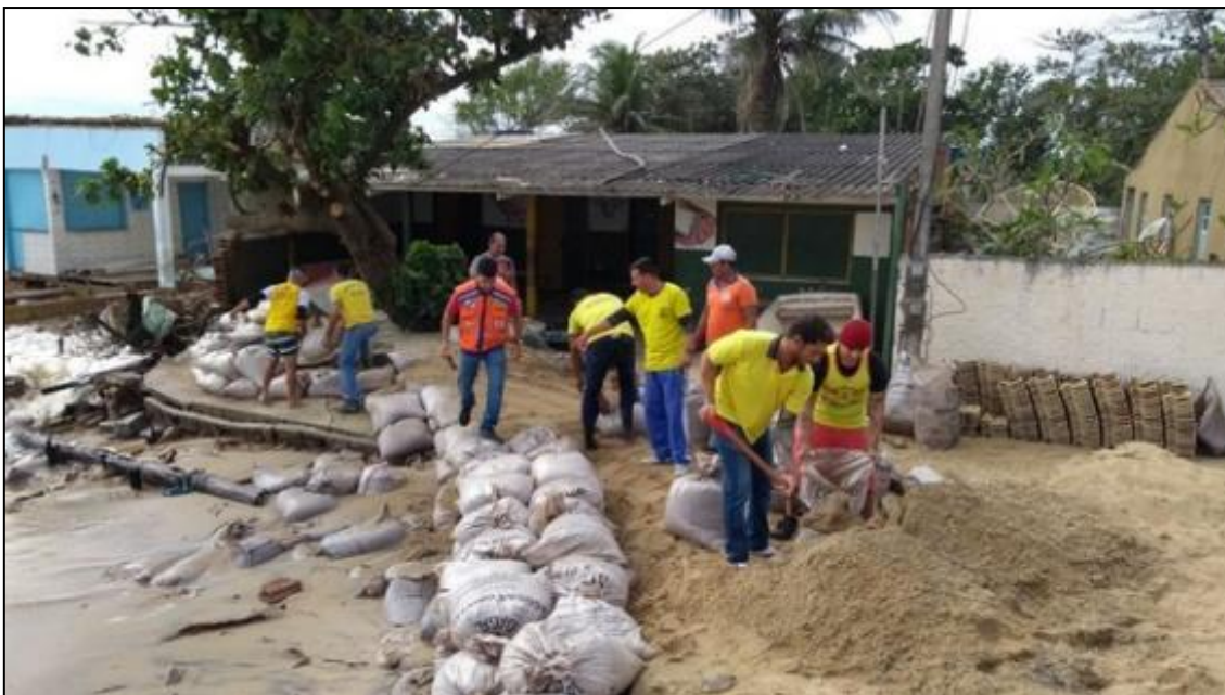
Fotografia 8 - Contenção construída pela da Defesa Civil na praia de Atafona
