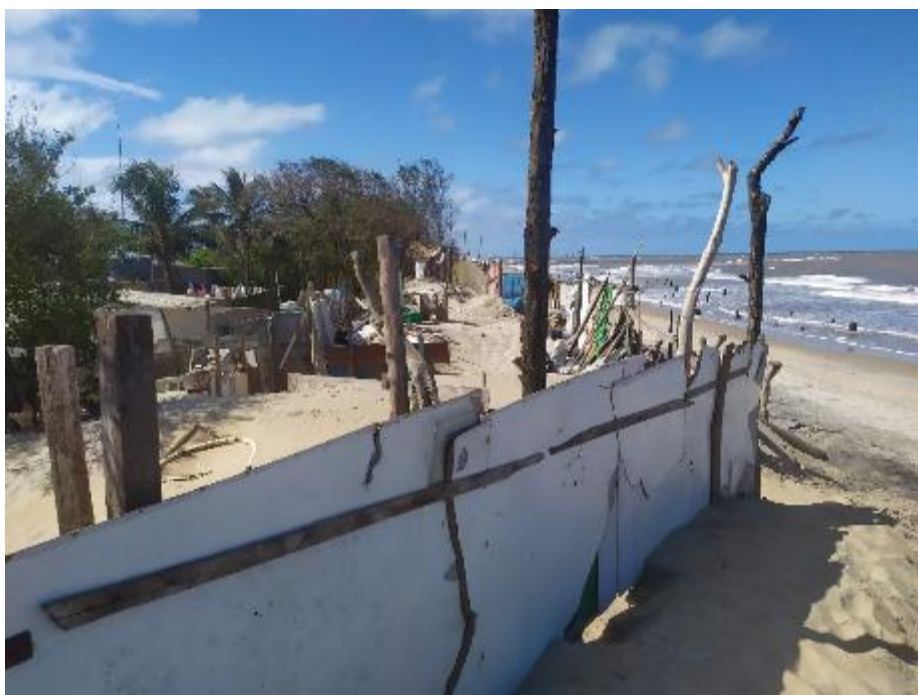
Fotografia 24 - Manutenção do "dique artesanal".
