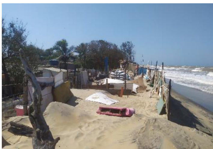
Fotografia 23 - Tentativas de construção de “Dique” artesanal.
