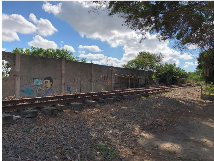
Figura 53 – O muro construído no entorno da comunidade Margem da Linha
