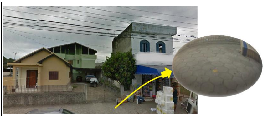
Figura 59 – Instalação de gasoduto na calçada – Rua Dr. Beda
