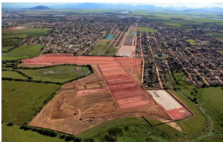
Figura 14 – Foto aérea de terreno em período de terraplanagem
