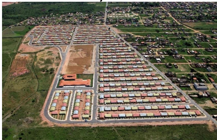
Figura 15 – Foto aérea – Conjunto Habitacional Novo Jockey
