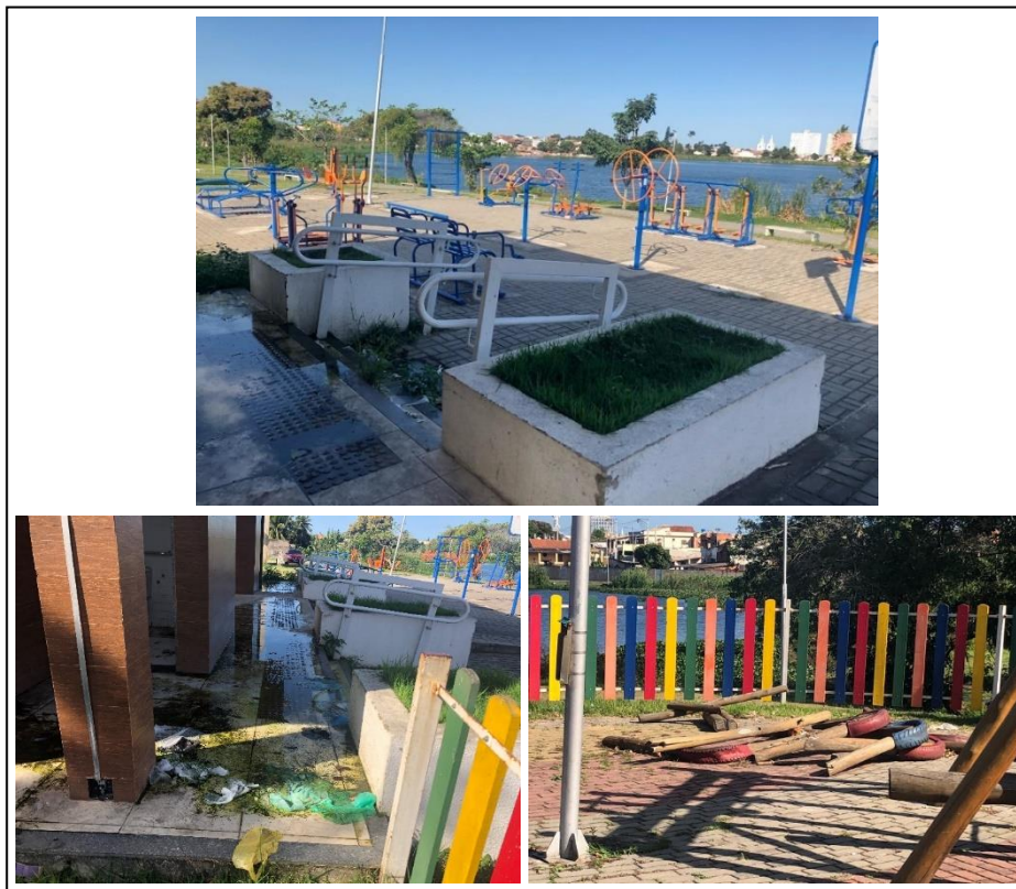
Figura 39 – Academia para idosos, playground quebrado e vazamento de esgoto
