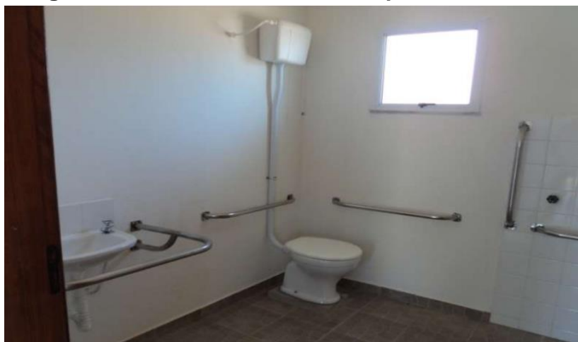
Figura 18 – Banheiro de casa adaptada do PMF
