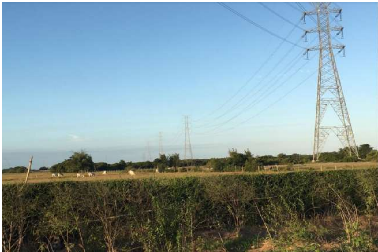
Figura 43: Torres e cabos de alta tensão em terras de Água Preta
