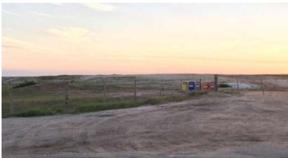
Figura 49: Trecho do aterro hidráulico do Porto do Açú na Estrada de Água Preta
