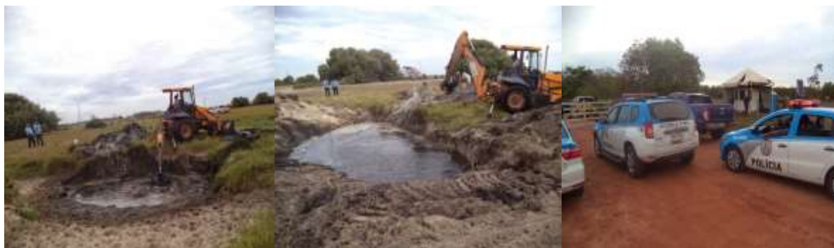
Figura 61: Limpeza dos tanques de água acompanhada de PM e seguranças da Prumo
