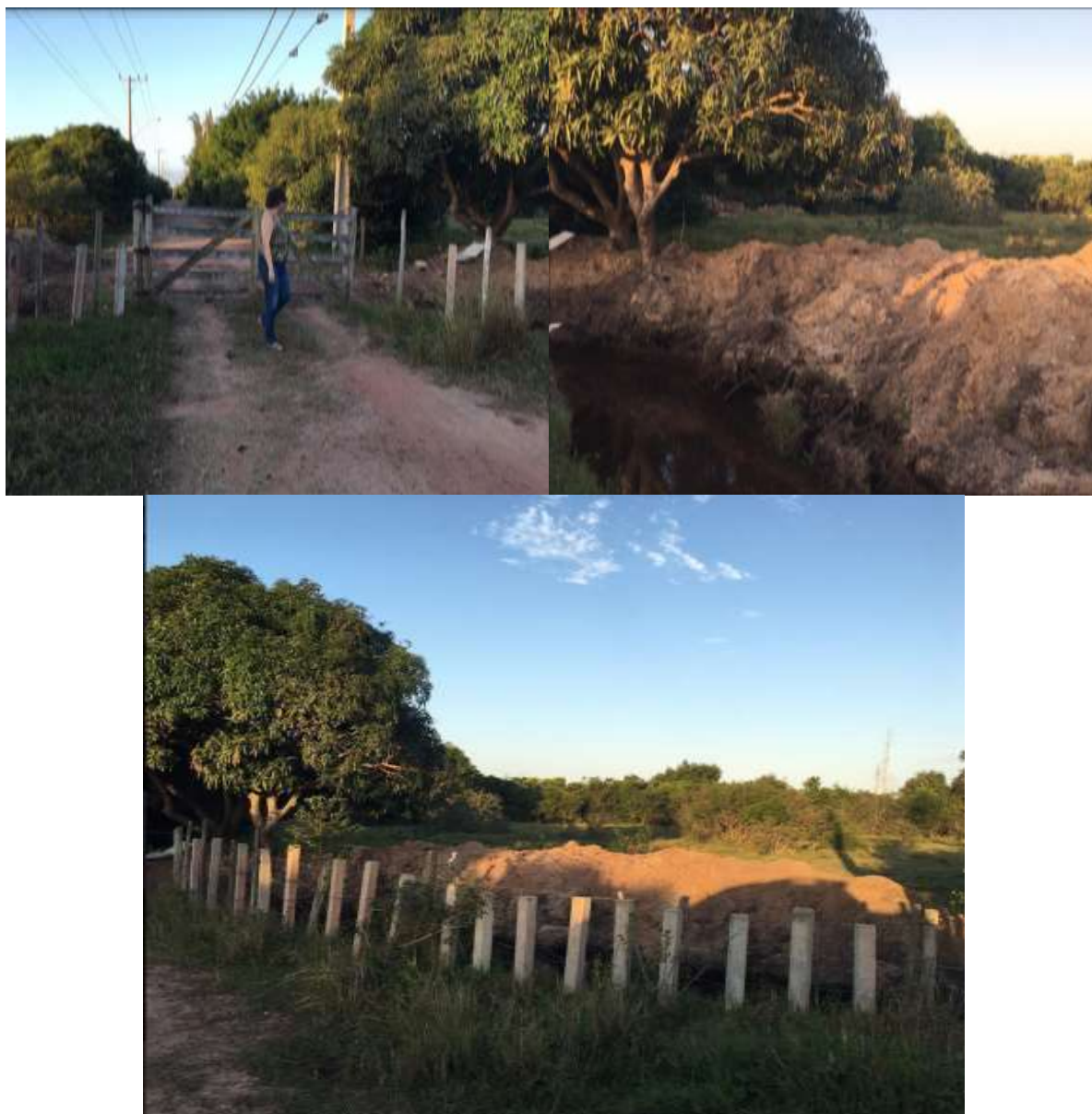
Figura 46: Cancela e valas laterais em estrada de acesso ao Porto
