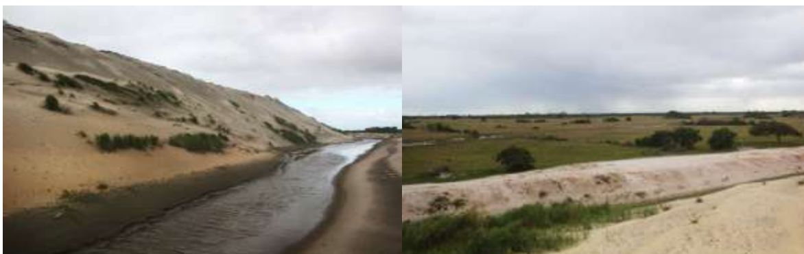
Figura 50: Outras imagens do aterro hidráulico do Porto do Açú
