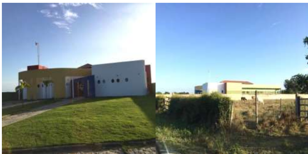
Figura 40: UBS (frente e lateral) em Palacete
