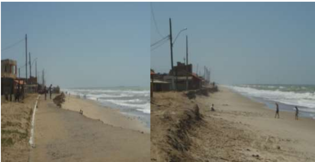
Figura 29: Praia do Açú afetada pelo processo erosivo
