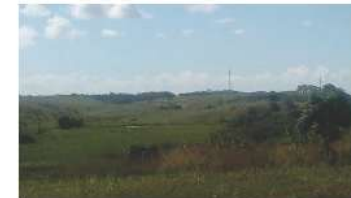
Área onde havia um lão, desativado
