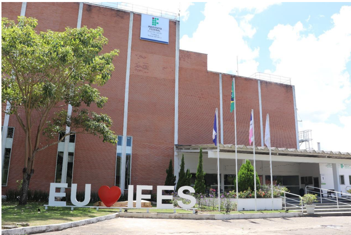
Foto 20: Vista parcial do campus Nova Venécia. Autoria: IFES, 2021.
