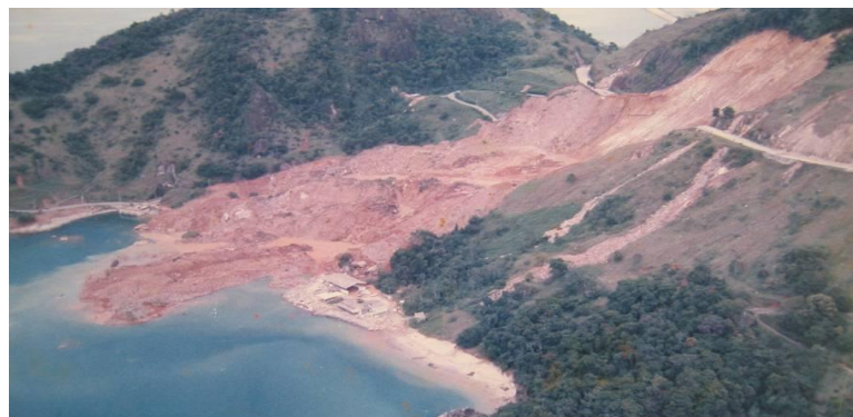
Figura 16 – Deslizamento de terra sobre o laboratório da CNAAA, 1985
