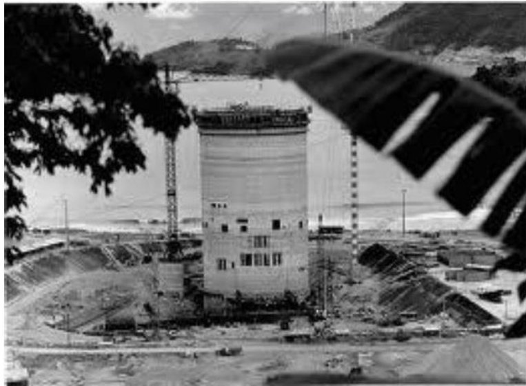
Figura 15 – Início de construção de Angra I
