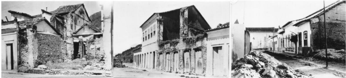
Figura 7 – Demolições na região central de Angra na década de 1940
