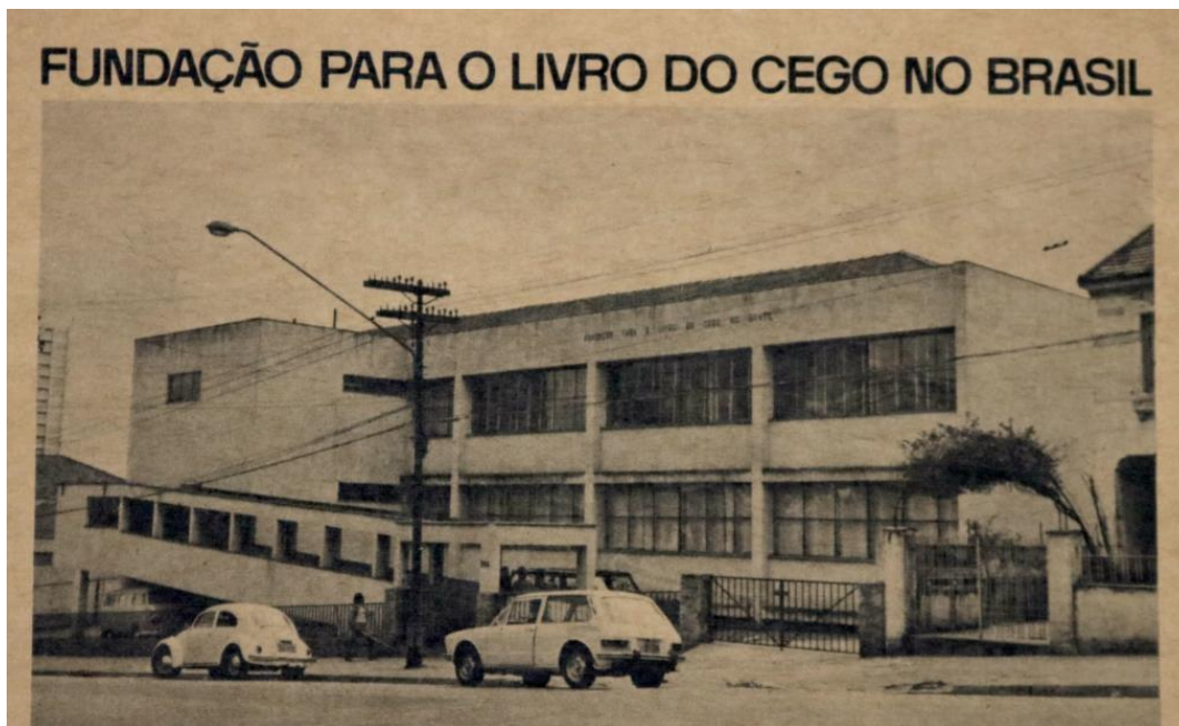
Figura 3 Fachada da Fundação para o Livro do Cego no Brasil, no endereço da Rua Dr. Diogo de Faria, n.º 558, Vila Clementino. São Paulo/SP.
