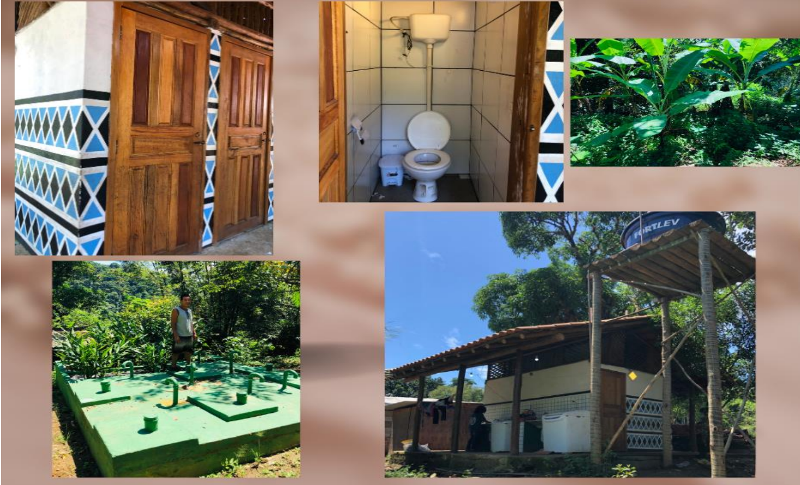
Figura 28: obra implementada a partir do modelo do Saneamento Ecológico
