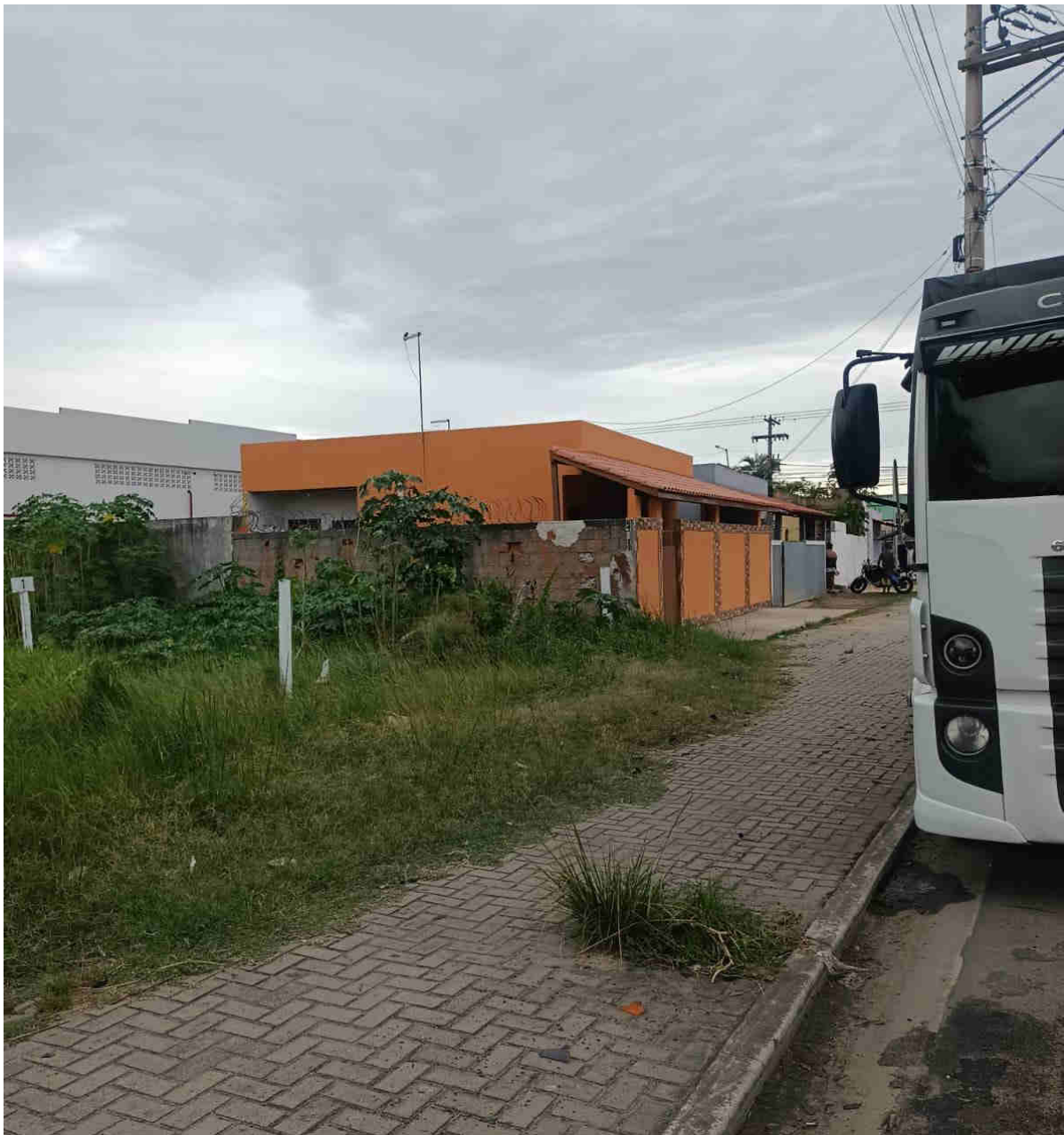
Figura 11. Residências unifamiliares no Riviera Ville. Fonte: acervo pessoal (2023).
