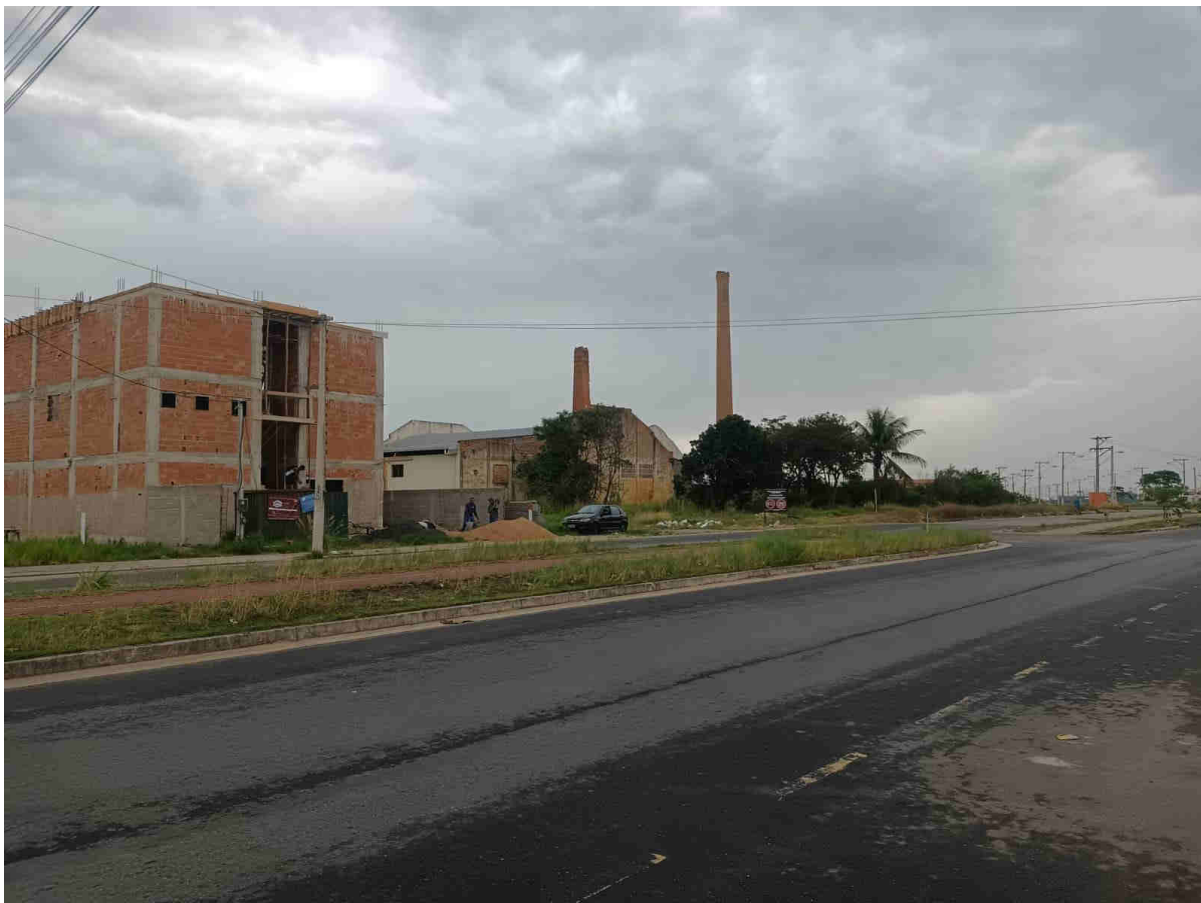
Construções no Riviera Ville com as torres da antiga Usina ao fundo. Fonte: acervo pessoal (2023).
