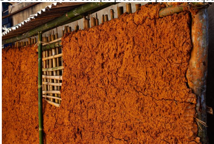
FIGURA 15: Muro de estuque produzido pelas Marisqueiras
