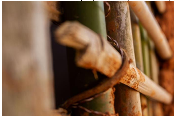
FIGURA 16: Muro de estuque produzido pelas Marisqueiras
