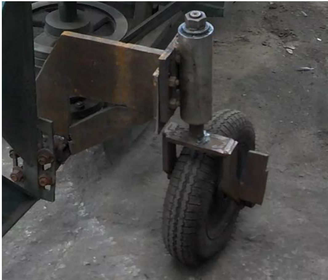
Figura 24. Alteração e reforço do sistema de rodagem.
