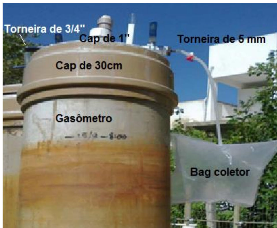
Figura 13 – Gasômetro com as conexões e bag coletora de biogás.
