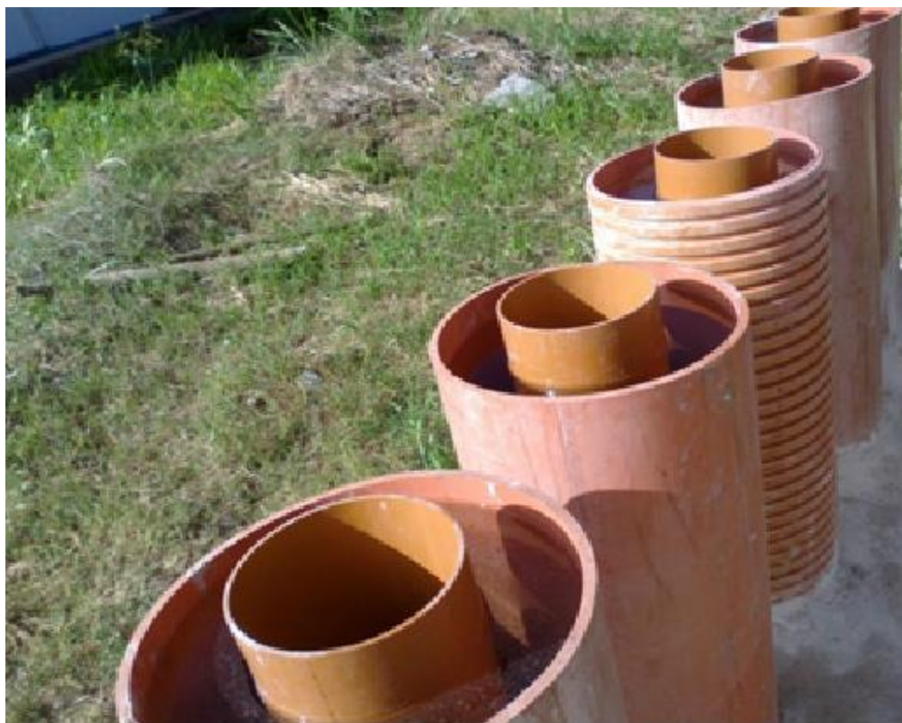
Figura 15 – “Selo de água” e fermentador em teste de impermeabilização.
