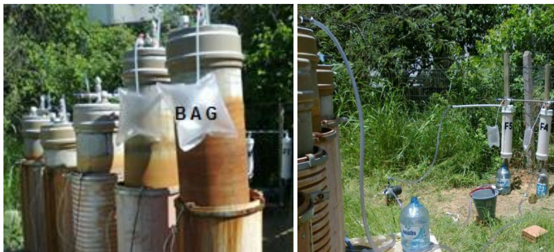
Figura 23 – Coleta de biogás nos biodigestores e nos filtros
