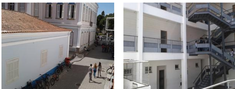
Figura 5 - Partes internas do Liceu de Humanidades. Primeira foto: pátio lateral de acesso à entrada principal. Segunda foto: anexo III com escadaria de acesso aos andares superiores. Fonte: Fotografias de Cleber Teixeira de Oliveira
