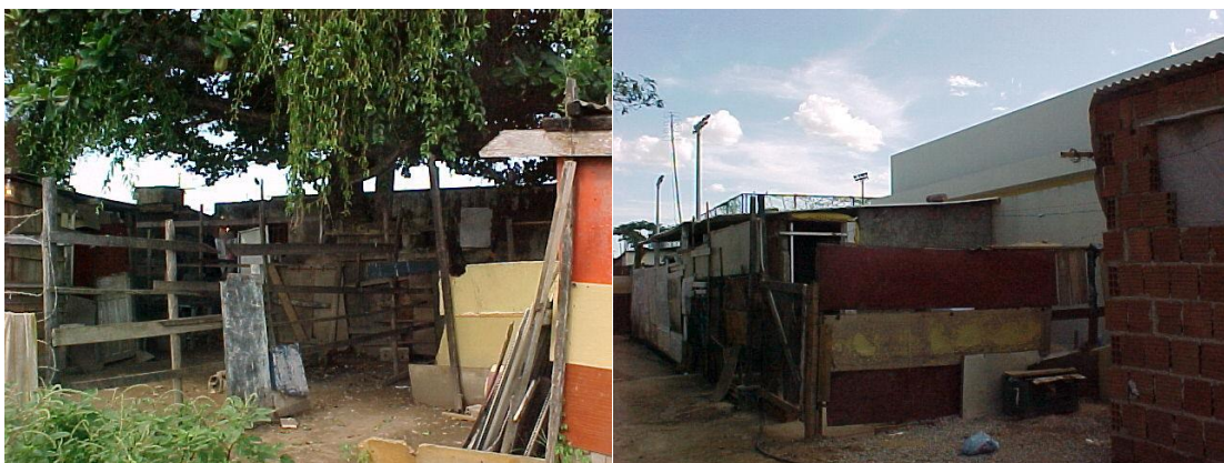
Figuras 12, 13 e 14: Alguns barracos construídos nas ruínas do Matadouro
