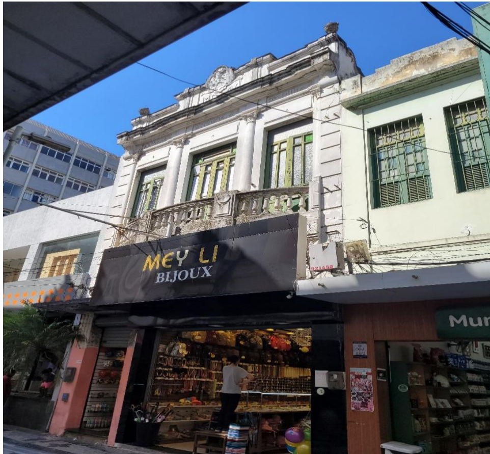
Figura 2: Fachada frontal de um sobrado situado na Rua Governador Teotônio Ferreira de Araújo
