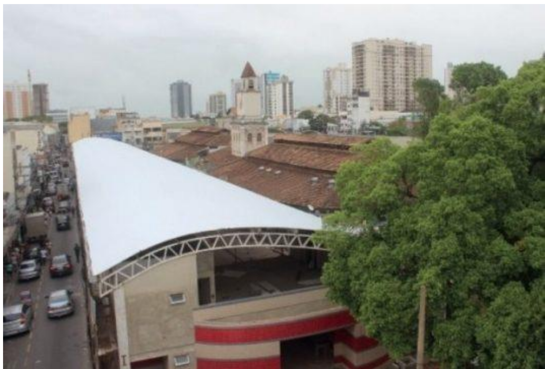
Figura 5: Telhado do Camelódromo
