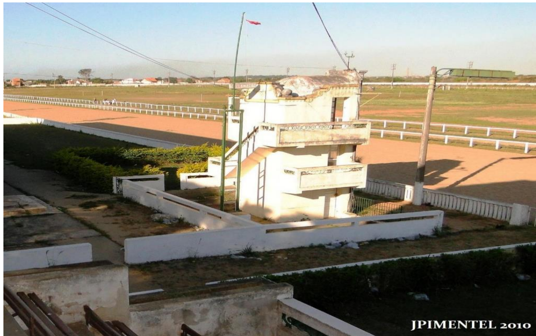
Figura 25: Pavilhão de chegada antes da sua demolição
