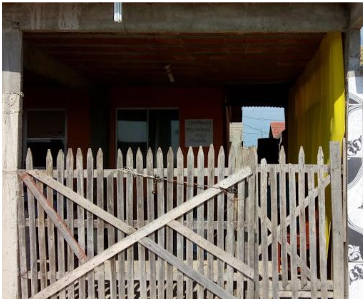
Figura 64 – Fachada do ponto de pregação em conjunto habitacional do Morar Feliz
