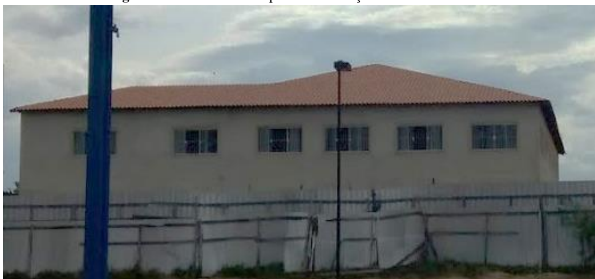
Figura 67 – Escola Municipal em construção na “Faixa de Gaza”
