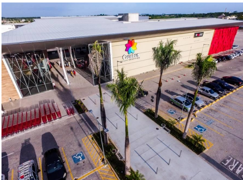
Figura 55 – Imagem da fachada e do estacionamento do Shopping Plaza Guarus
