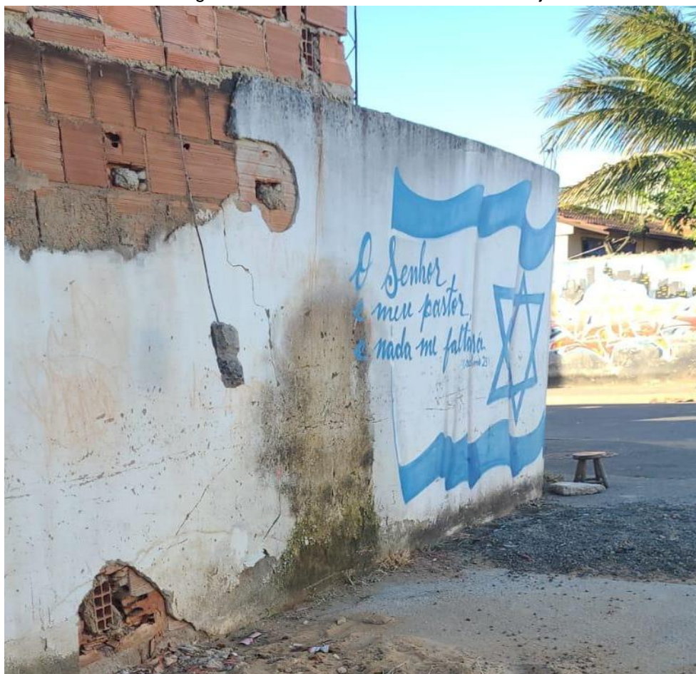
Figura 4 – Muro de uma das casas do Conjunto
